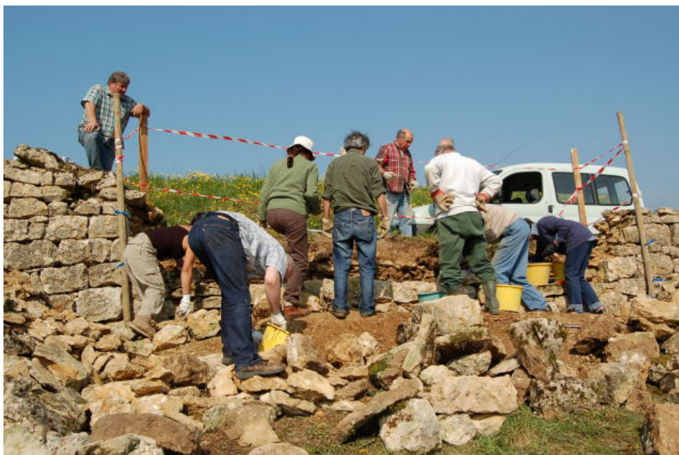
Stage d'initiation à la restauration des murs de pierre sèche à Cruzille en avril 2004
