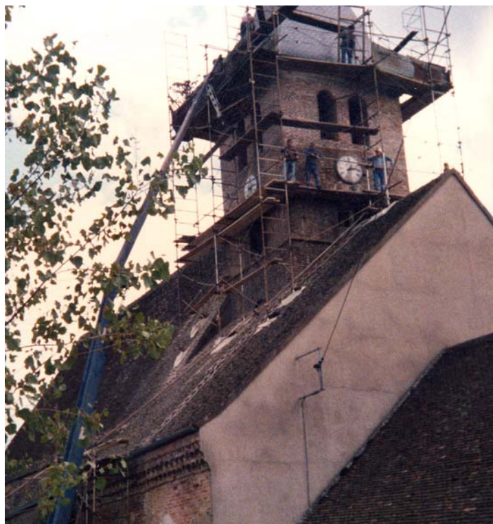
Restauration du clocher de l'église de Sagy Entreprises Péhu (maçonnerie) et Gauthier (charpente-couverture)
