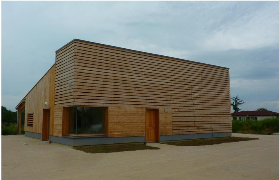
Donc ça, c'est un **privé**, à côté de **Saint-Boil**, et là on est en plein dans le bâtiment écologique passif. C'est une volonté du maître d'ouvrage de faire ça. Des murs en ossature bois avec une isolation en ouate de cellulose et bardé à l'extérieur. Là, par exemple, le projet qui s'est finit, et là aujourd'hui le vieillissement qui est plutôt correct.
