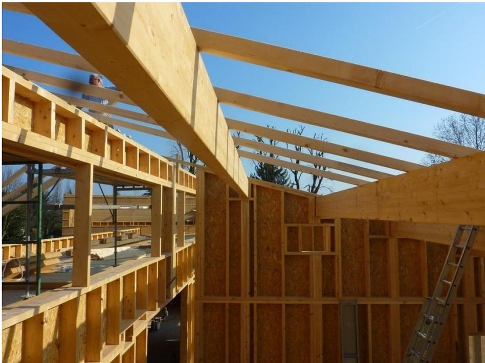
Ensuite, on part **dans la Nièvre à Luzy** ou on a **procédé à l'extension d'un gymnase**. Il y a de la maçonnerie mais moi je vais vous parler de l'extension en bois. Donc pareil, on est partis toujours sur un système en ossature bois. Une charpente classique en lamellé collé. A Luzy c'est pas loin du Parc du Morvan, donc l'obligation
